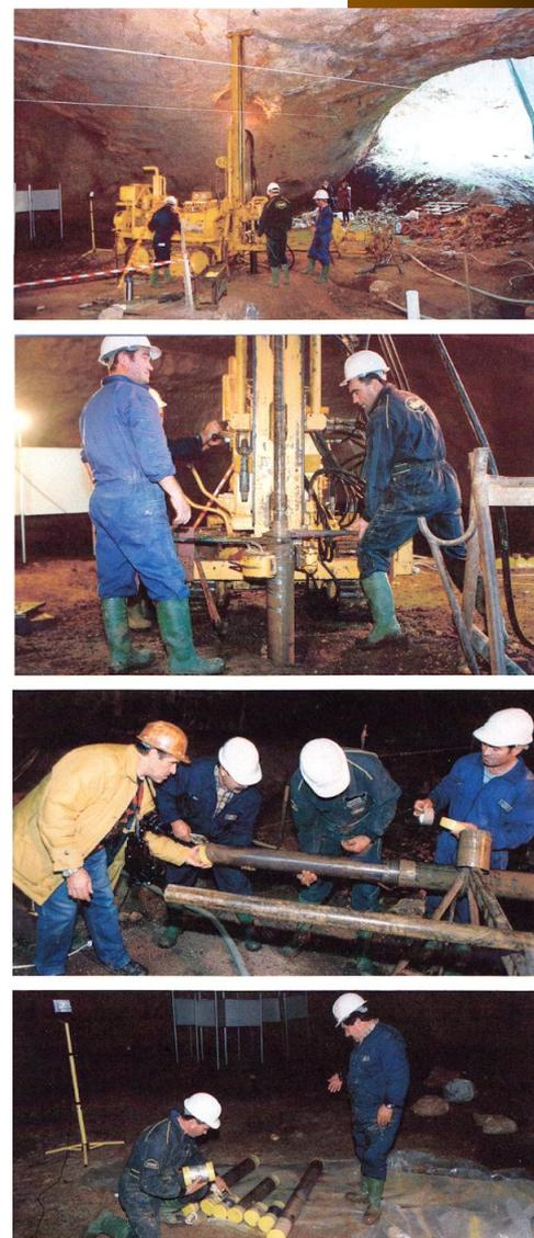
**Figura 20.** Sondagem mecânica do preenchimento sedimentar da gruta.
